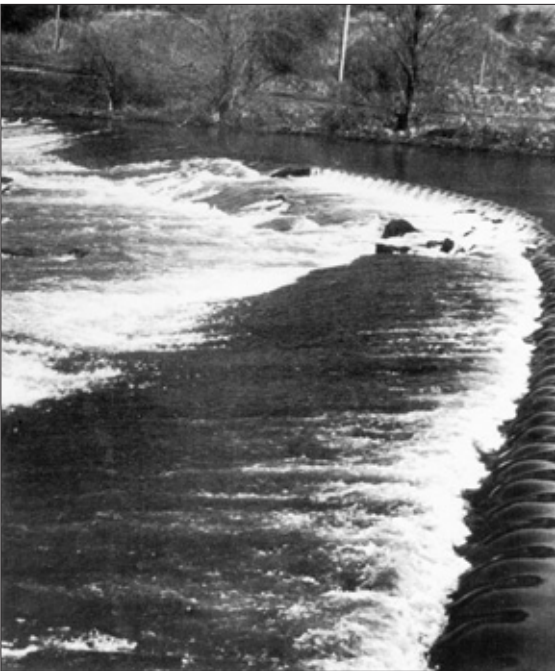
Barrage sur le Doubs. Les tourbillons créés au niveau du barrage, en activant le mélange entre l'air et l'eau, jouent un rôle essentiel dans le processus d'auto-épuration de la rivière
